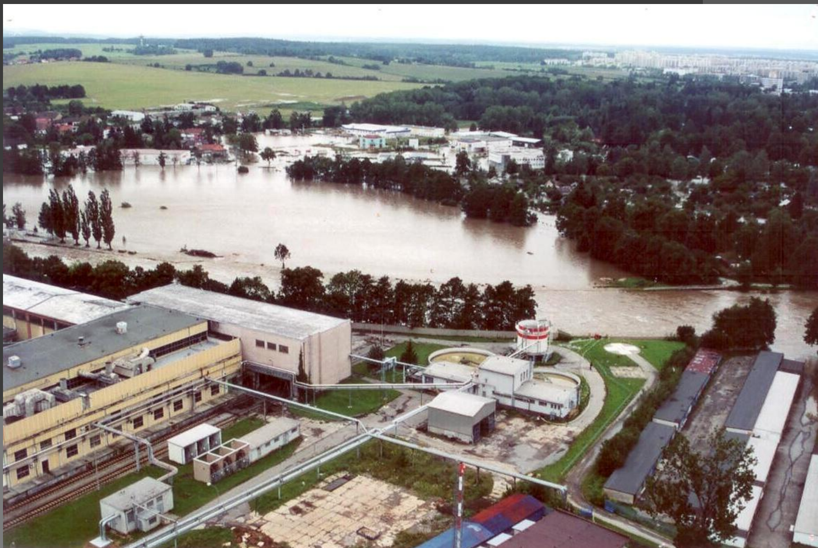
200208 povodně České Budějovice, heliport nemocnice
